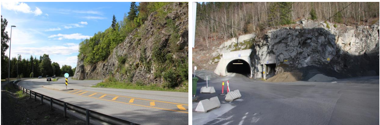
Figur 4-2: Gamle Ringeriksvei gir atkomst til steinbruddet
