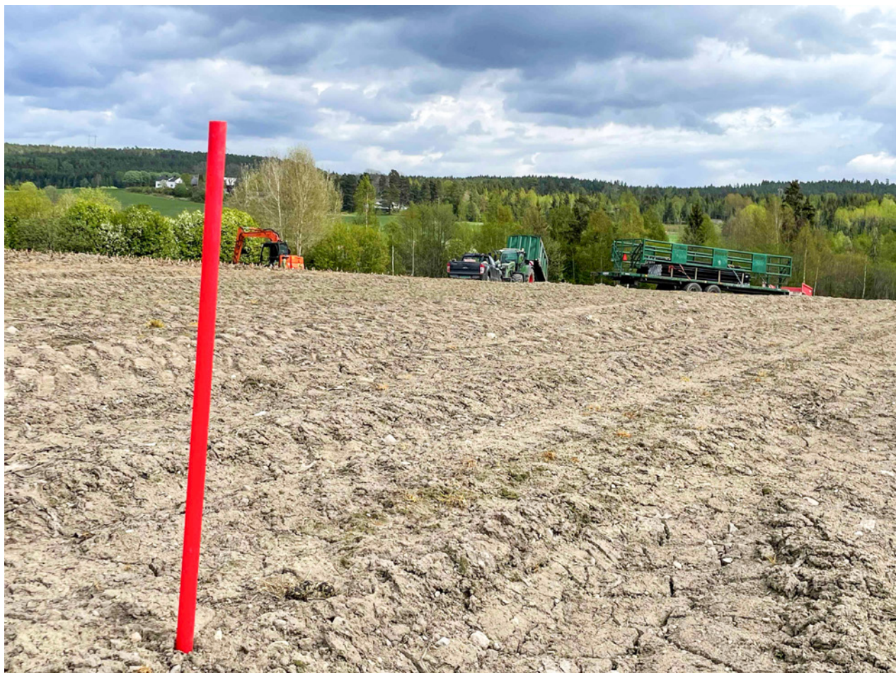
Dreneringsarbeid i hekketid, Oppsand vest. Foto Morten Gaathaug
